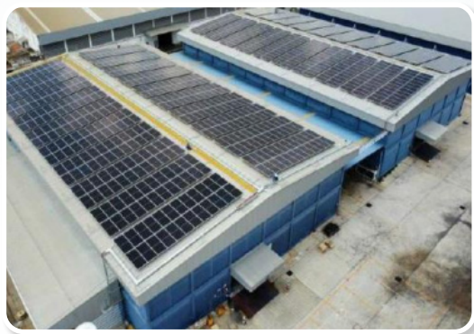
หลังคาอาคารโรงงานเดิม
